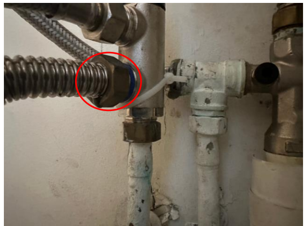
Goutte-à-goutte au droit du raccord du ballon d'eau chaude sur la nourrice
