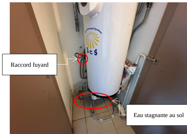
Localisation du goutte-à-goutte au droit du raccord du ballon d'eau chaude sur la nourrice
