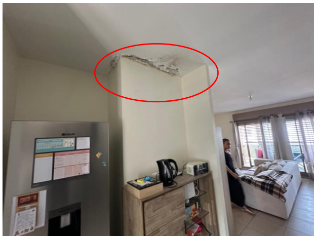
Infiltration au plafond et sur les murs de la cuisine et du salon de l'appartement C16
