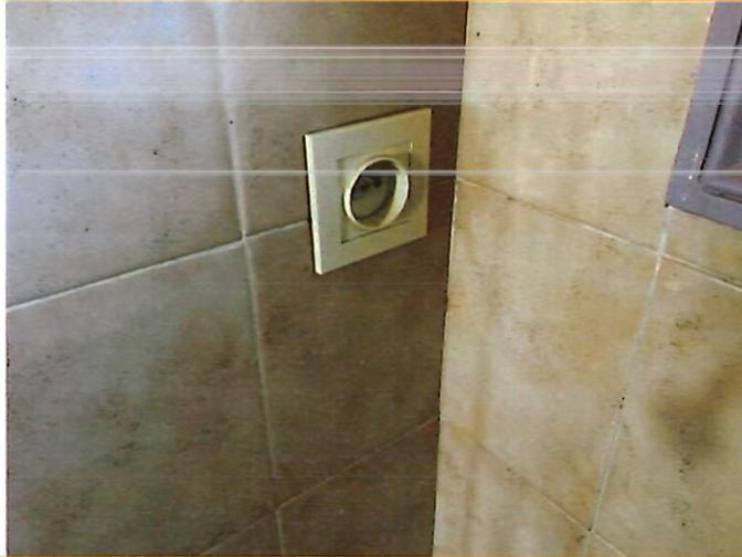
**Description :** Locaux contenant une baignoire ou une douche : la continuité électrique de la LIAISON EQUIPOTENTIELLE supplémentaire, reliant les ELEMENTS CONDUCTEURS et les MASSES des MATERIELS ELECTRIQUES, n'est pas satisfaisante (résistance > 2 ohms).
